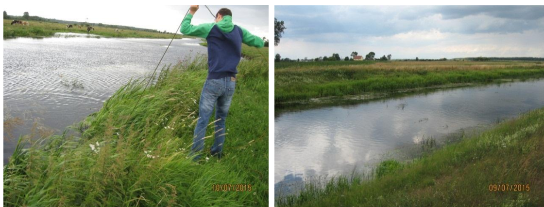
Rys. 9. Punkt pomiarowo-kontrolny nr 13 - Sojczyn
