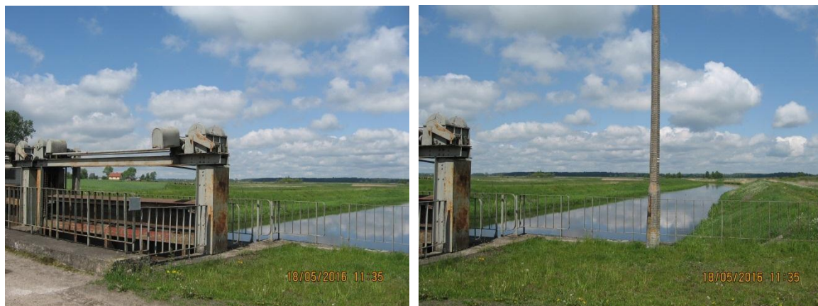
Rys. 3. Punkt pomiarowo-kontrolny nr 1 – Ełk (1)
