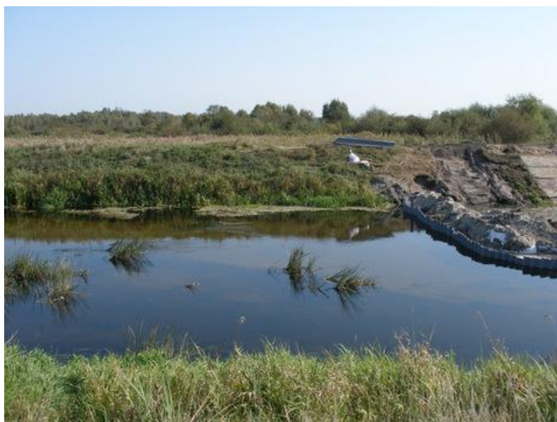
Fot. 17. Prace hydrotechniczne w korycie w sąsiedztwie st. 1 Ełk 1 i st. 12 Kanał Rudzki Modzelówka, jesień 2018
