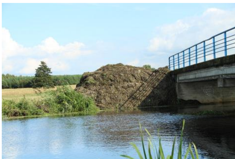
Fot. 24. Wykoszone makrofity z koryta, składowane na brzegu lewym, st. 13 Kanał Rudzki Sojczyn Grądowy, jesień 2017
