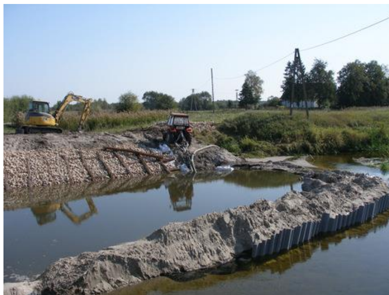
Fot. 18. Prace w korycie i jaz piętrzący w sąsiedztwie st. 12 Kanał Rudzki Modzelówka, jesień 2018
