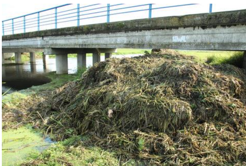
Fot. 23. Wykoszone makrofity z koryta, składowane na brzegu prawym, st. 13 Kanał Rudzki Sojczyn Grądowy, jesień 2017
