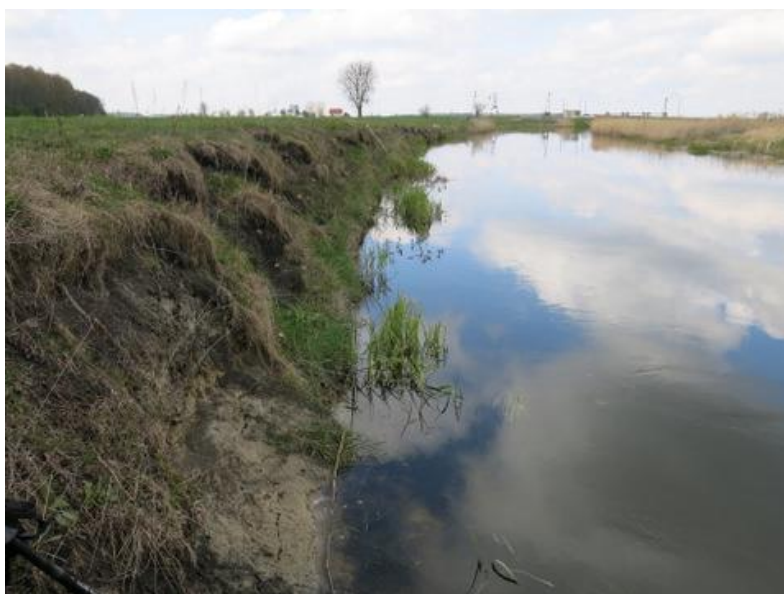
Fot. 15. Erozja brzegów, brak strefy przejściowej, st. 12 Kanał Rudzki Modzelówka, wiosna 2016
