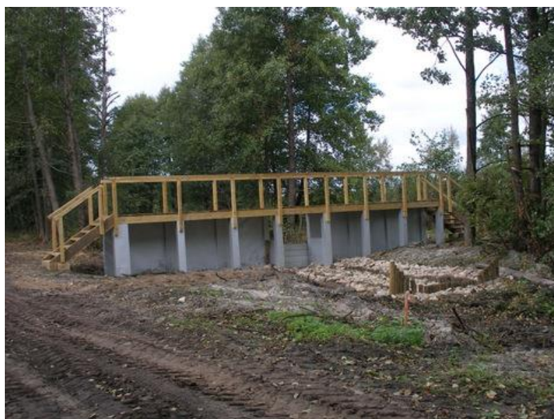
Fot. 20. Prace hydrotechniczne w korycie na st. 10 Kanał Kapicki góra, jesień 2018
